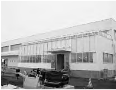
▲建設中の(仮称)新学校給食共同調理場
