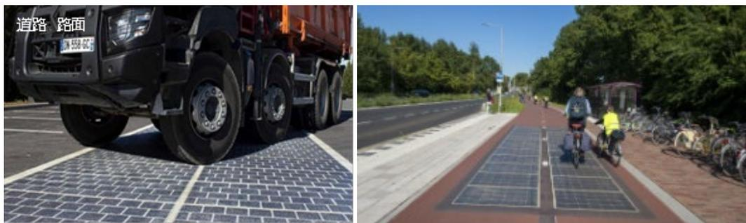
写真 B-5-4 路面舗装型太陽光（左）と自転車専用道路への敷設例（右）
