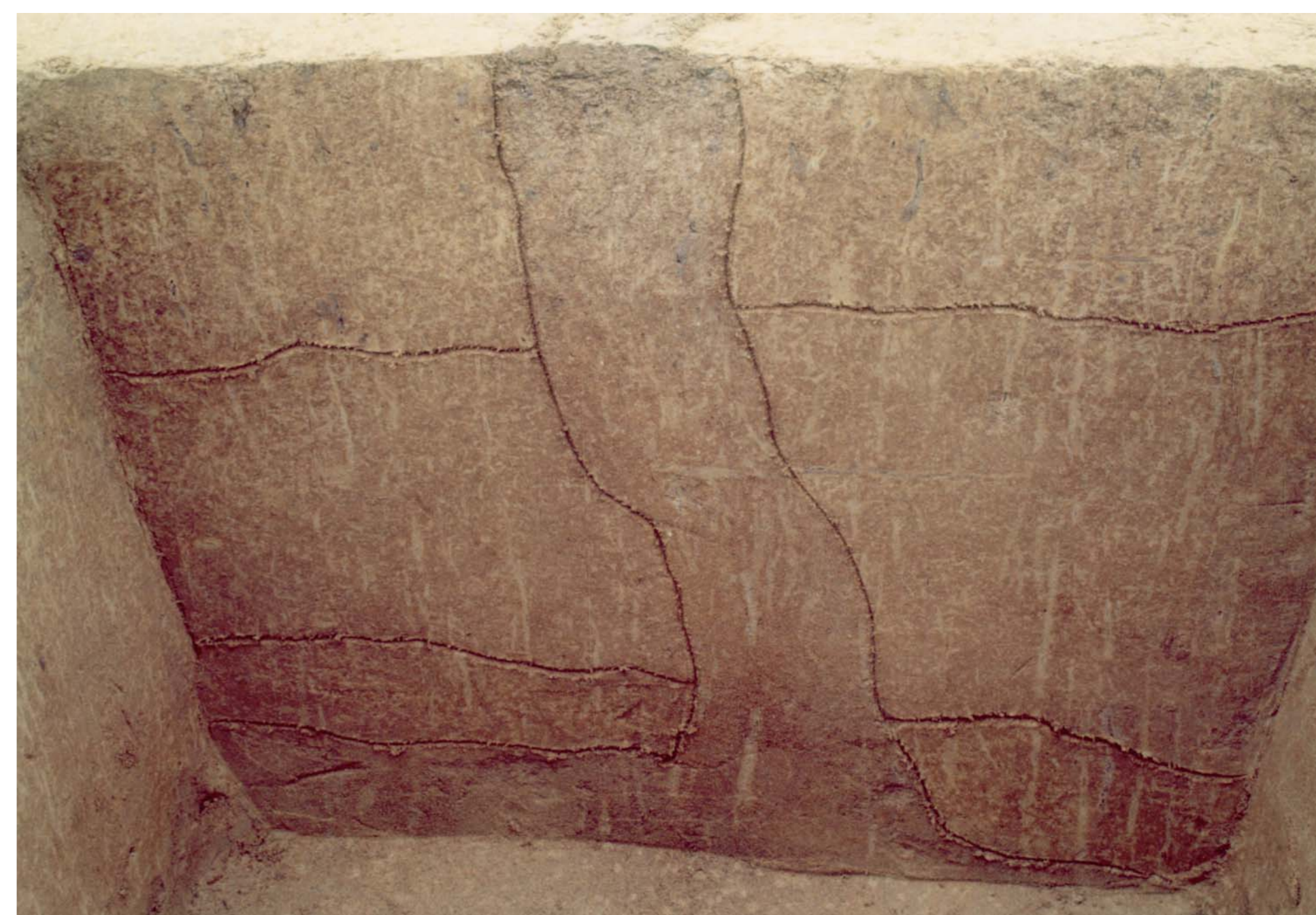
噴砂の断面を確認した様子
