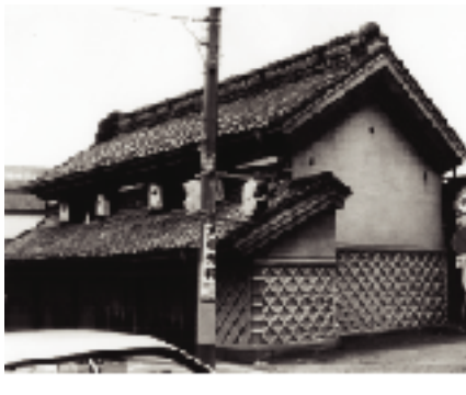
どぞうづくり 修理前の二階建土蔵造倉庫
