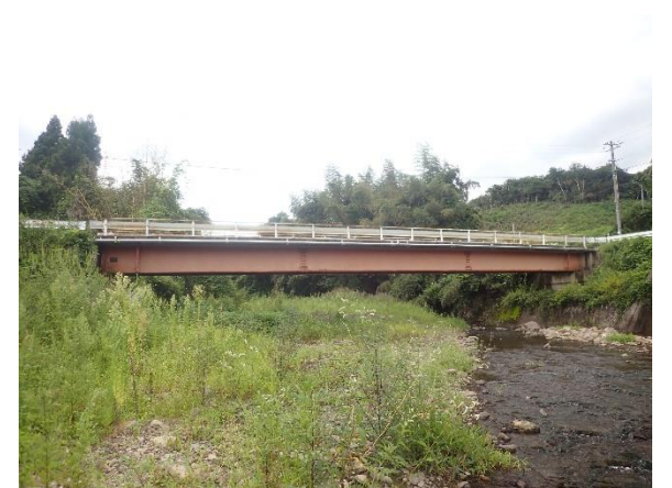
薬師橋(R3年、修繕前)
