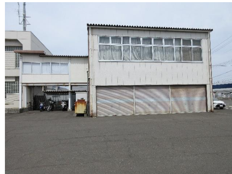
建築・解体予定の消防団本部
