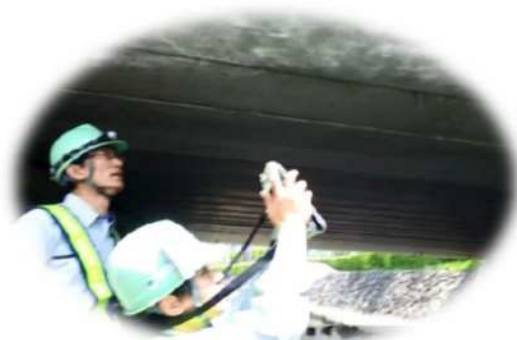
【タブレットによる点検】
