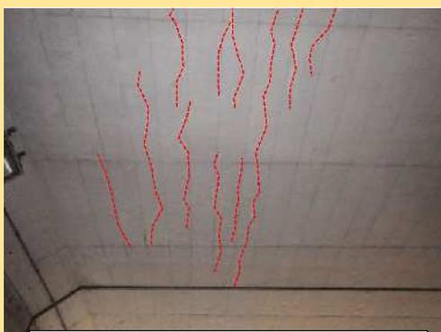
③トンネルの天井や側壁に発生したひび割れ。
