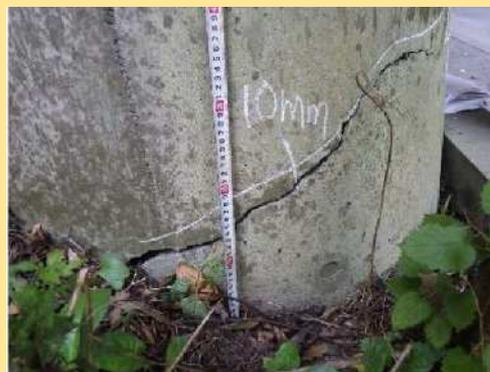
④トンネル入口付近の壁に発生したひび割れ。
