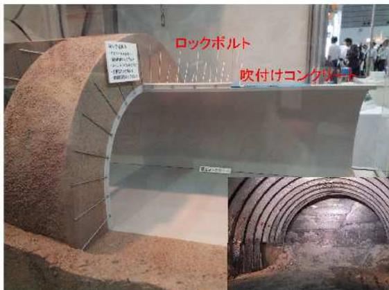
ロックボルトと吹付けコンクリートで地山を補強して自立させる工法。現在の主流。
