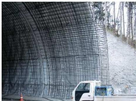
坑口部の覆工は鉄筋コンクリート
