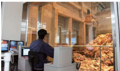
焼却ごみのごみピット
