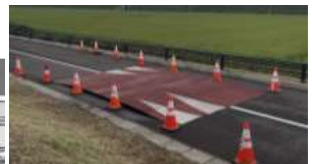
仮設ハンプ設置状況
