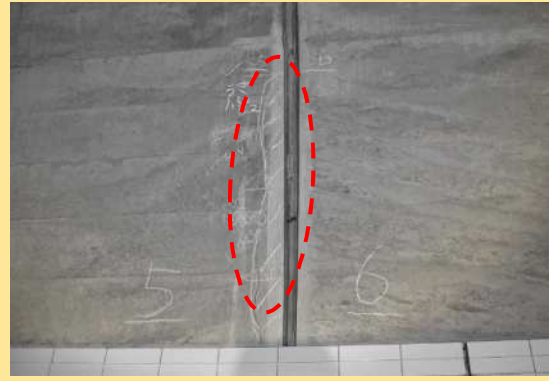
②横断目地付近に生じたうき。監視する。
