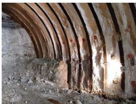
トンネル内の覆工は無筋コンクリート
