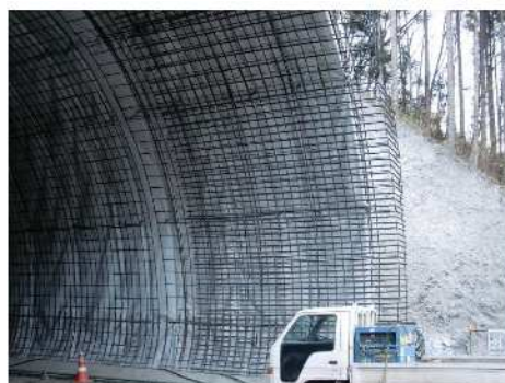
坑口部の覆工は鉄筋コンクリート
