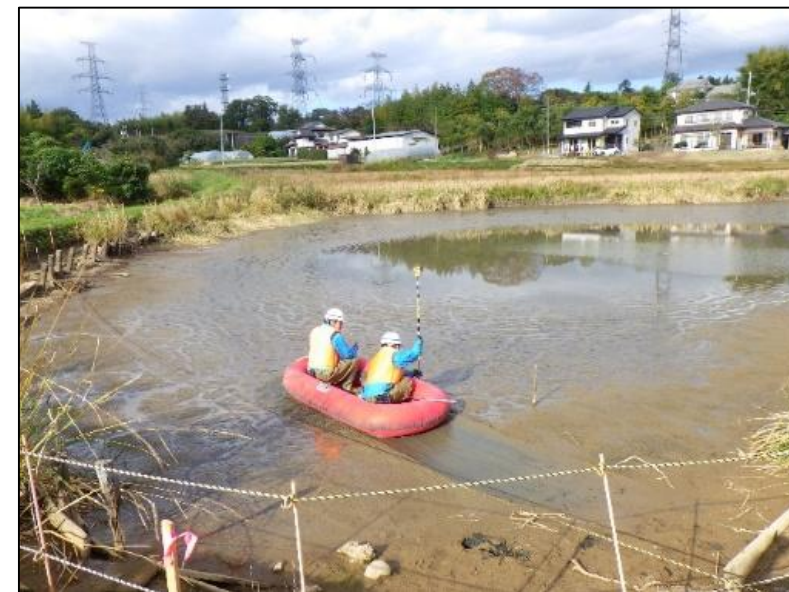
農業用ため池堆積土砂調査状況
