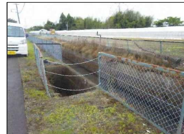
不備のある安全施設の修繕
