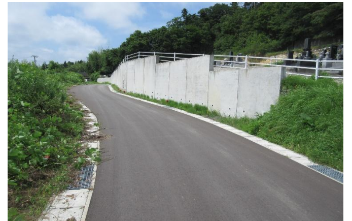
愛島53号線(上施工前・下施工後)
