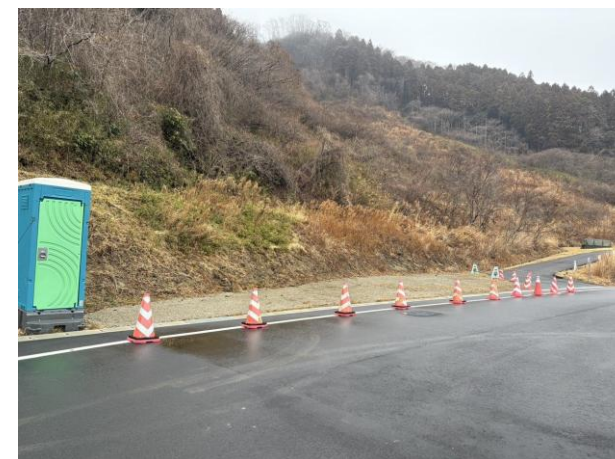
駐車場整備箇所の様子
