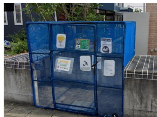
(ごみ収容設備の設置)
