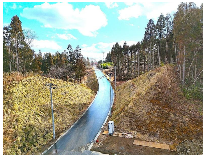
道祖神愛島台線(R7工事区間)
