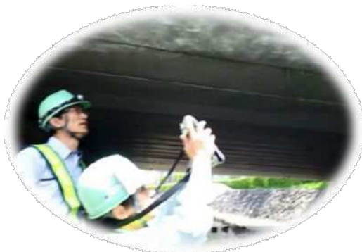
【タブレットによる点検】
