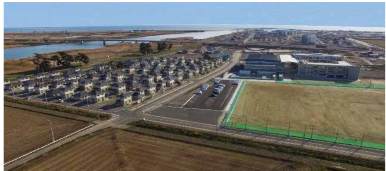
関上地区災害公営住宅 戸建住宅(第1期 関上西第一団地)
