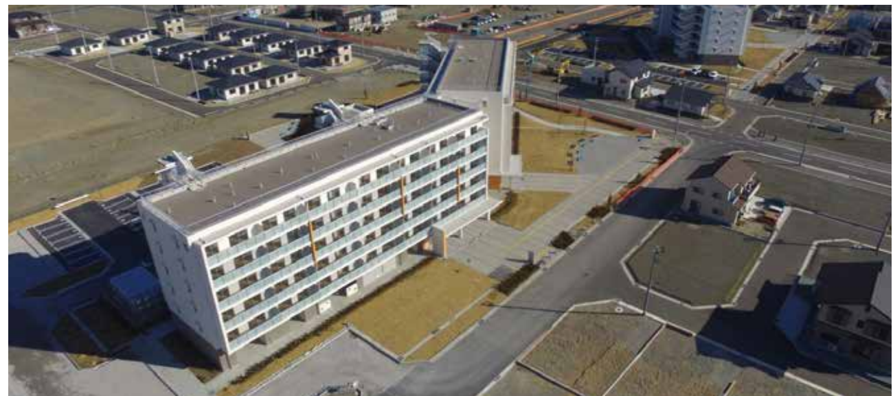
関上地区災害公営住宅 集合住宅(第3期 関上中央第二団地)
