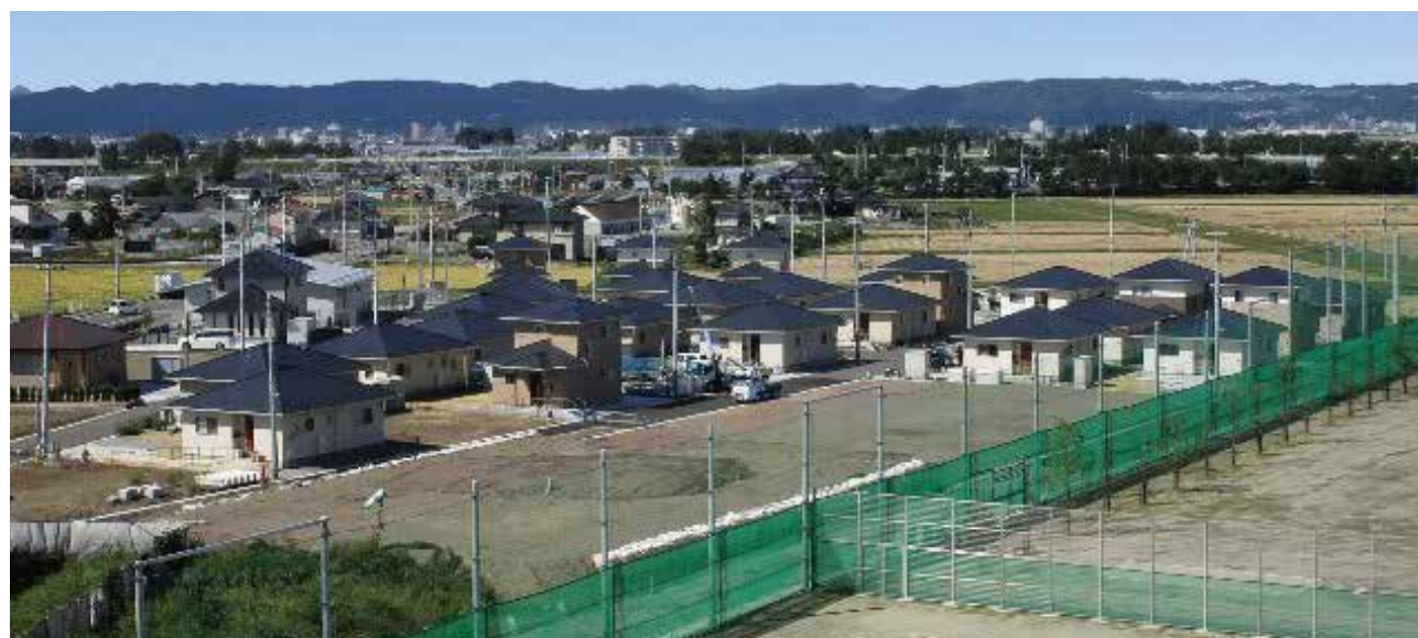
関上地区災害公営住宅 戸建住宅(第2期 関上西第二団地)
