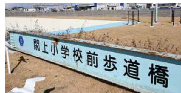
閉上小学校前歩道橋
