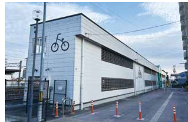
増設した名取駅西口自転車等駐車場
