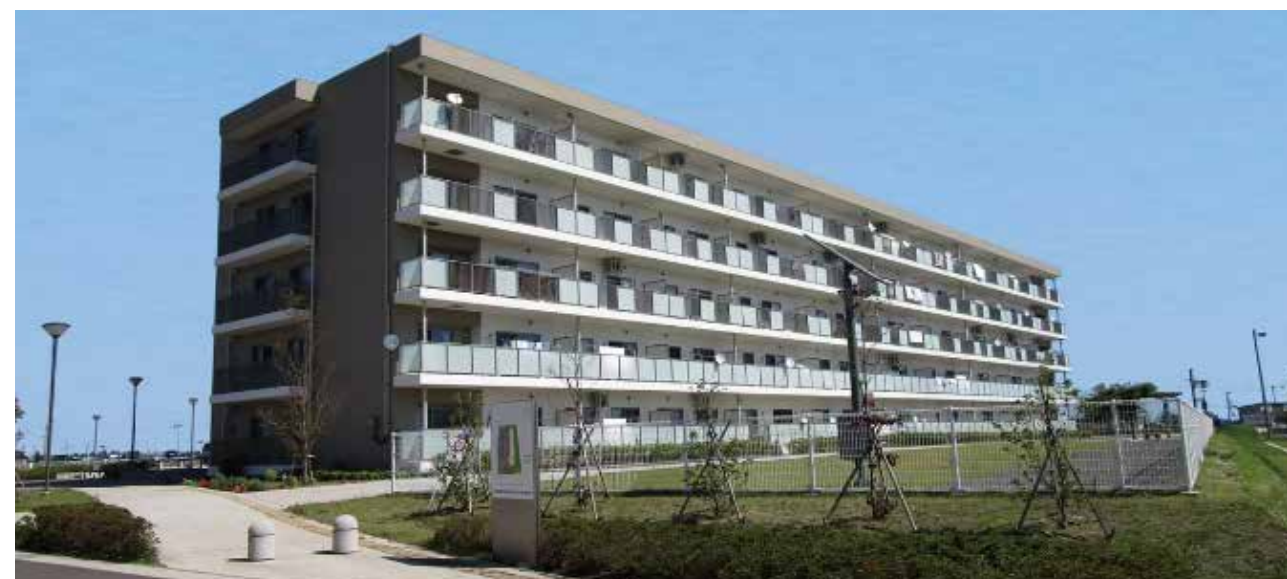
下増田地区災害公営住宅 集合住宅(美田園北団地)
