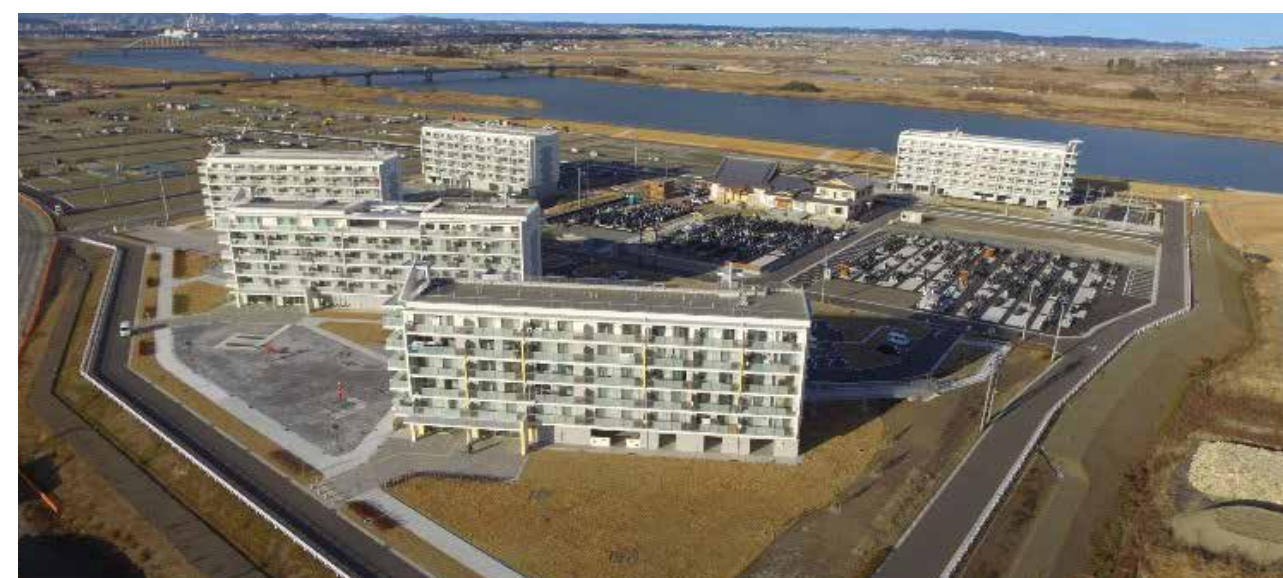
閑上地区災害公営住宅 集合住宅(第1期・第2期 閑上中央第一団地)
