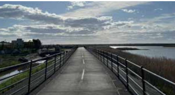
広浦湾西岸に付け替えられた一般県道仙台亘理自転車道
