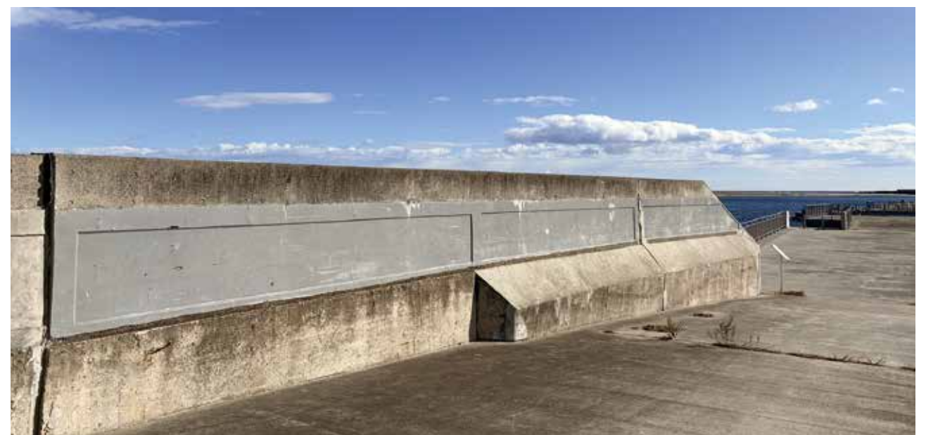
名取川河川堤防旧護岸
