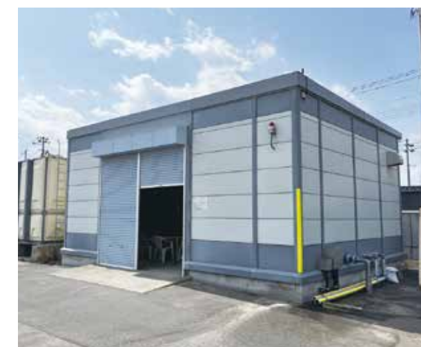
送水ポンプ室
