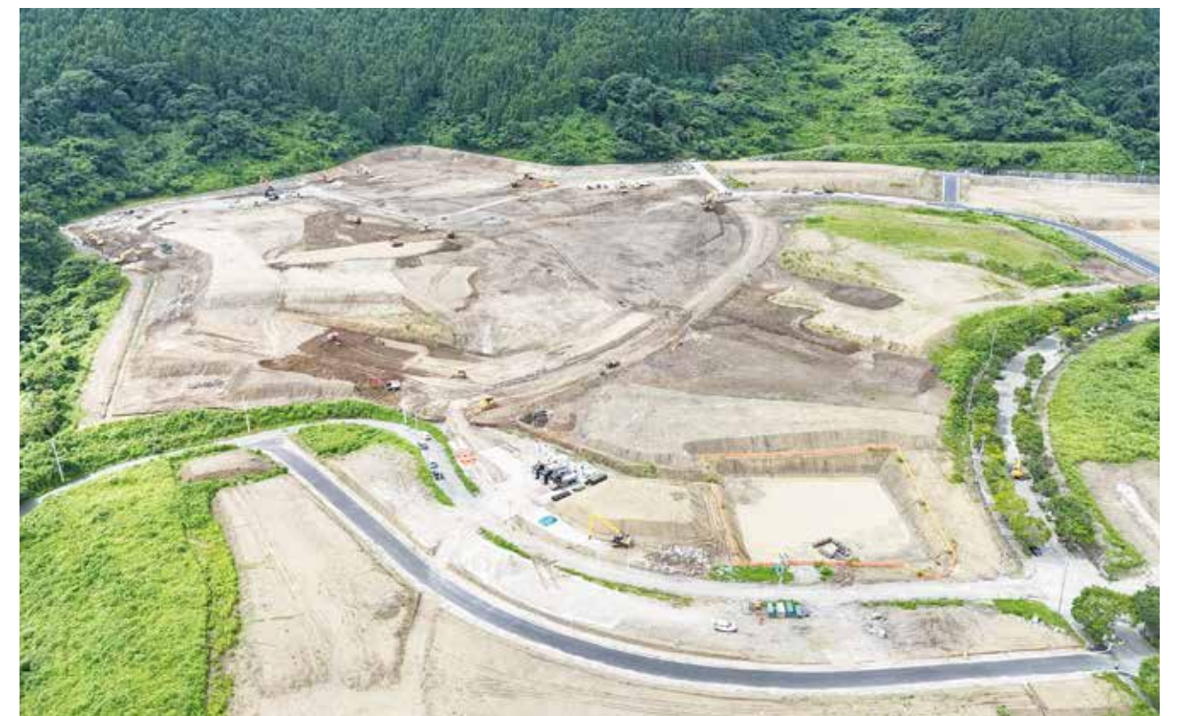
造成工事が進められる愛島西部工業団地（令和6年7月撮影）
