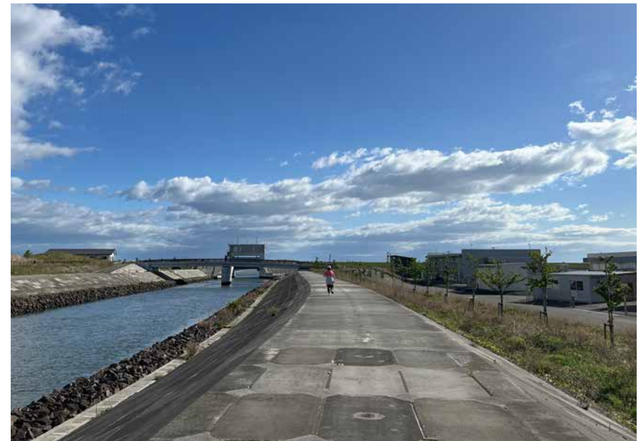
復旧後の貞山運河堤防(旧開運橋付近から名取川を望む)
