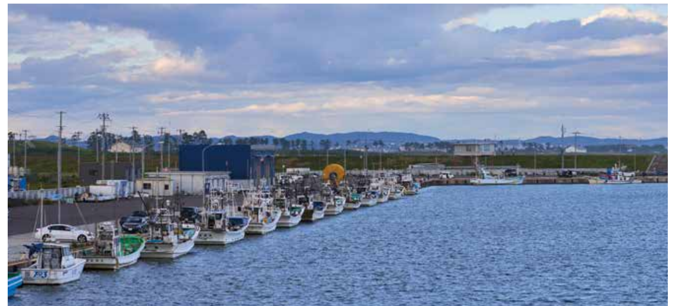
復旧後の閉上漁港
