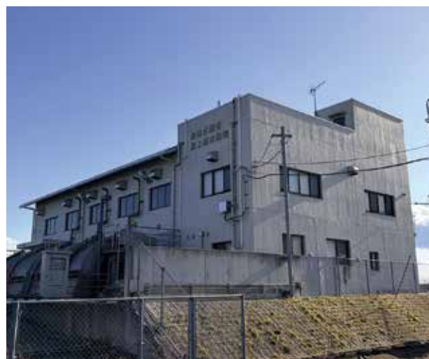
再建後の閑上排水機場
