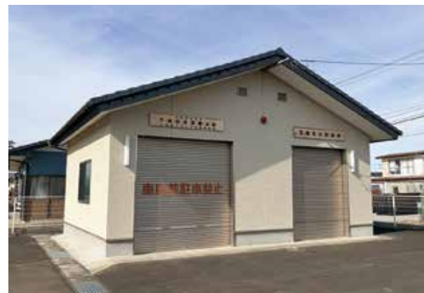
下増田水防倉庫(車庫併設)
