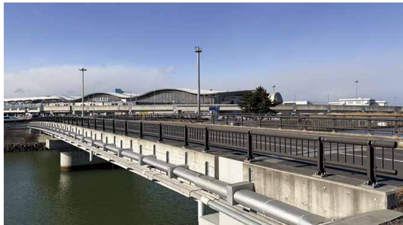
北釜橋(復旧後)
