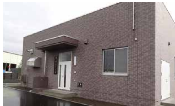
閑上中継ポンプ場(復旧後)
