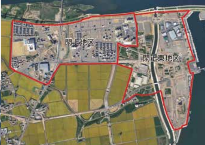
平成30(2018)年9月 関上地区の災害公営住宅の建築工事がさらに進み、小中学校も開校。関上東地区でも造成工事が始まっている
