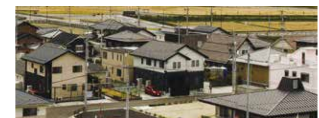
防災集団移転先団地
