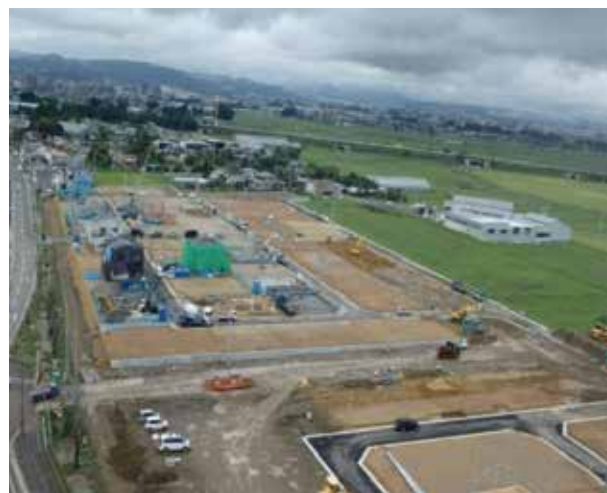
平成26年8月【一般戸建住宅の建築に着手】
