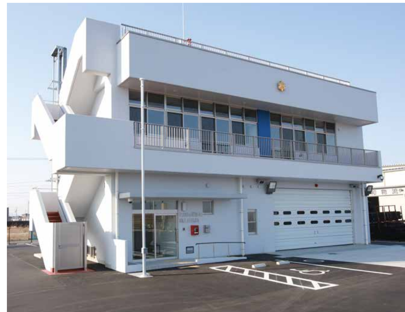
降下訓練設備も備えた消防署関上出張所
