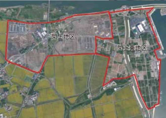
平成28(2016)年9月 関上地区の造成工事や災害公営住宅の建築工事が始まっている。関上東地区の土地区画整理事業は、認可直後で造成には着手していない
