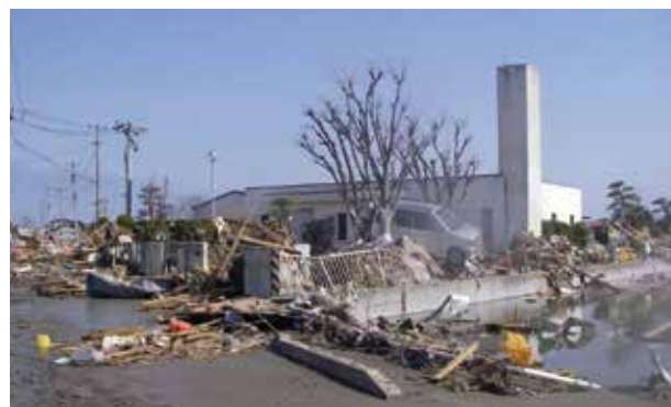
閑上中継ポンプ場(震災時)
