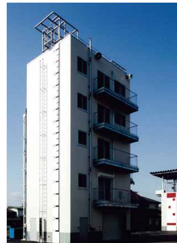
復旧した救助訓練塔
