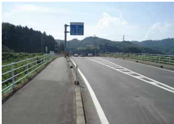
市道上田高線(補修工事後)
