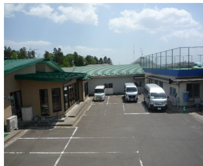
右手側が居住スペースのある本館
