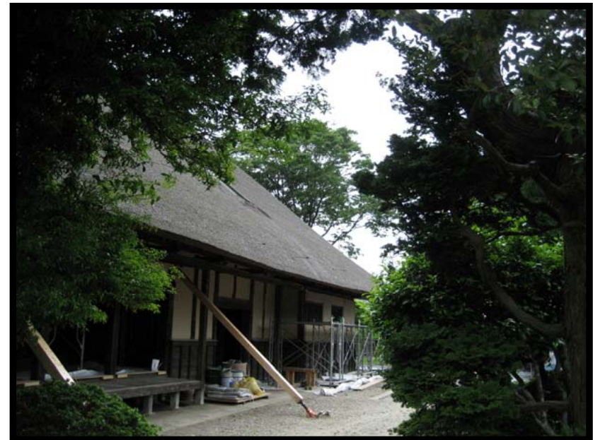
修復工事中の母屋
