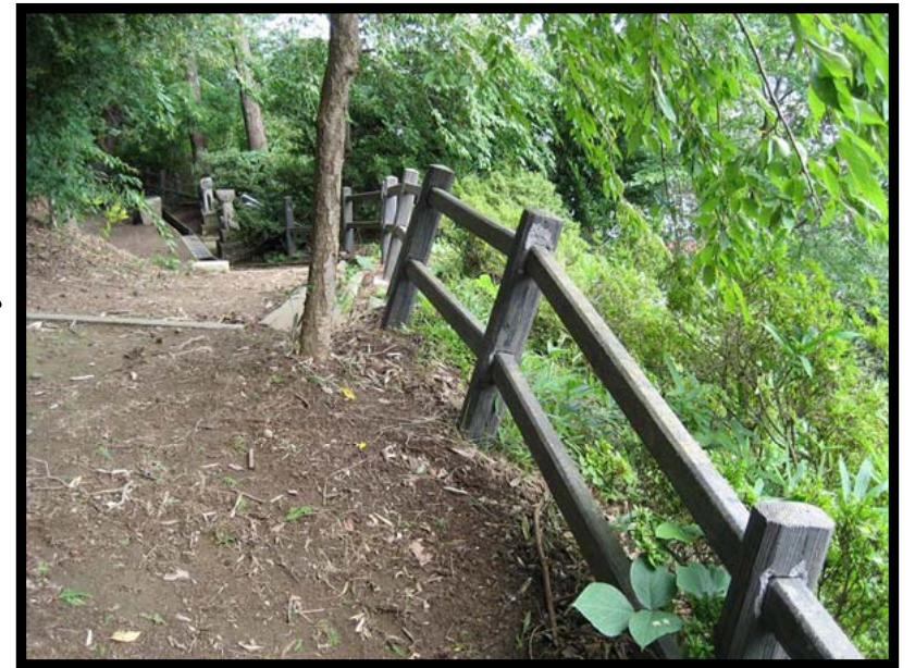
地震の揺れで傾いた柵
