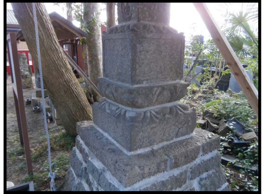
修理後の様子
