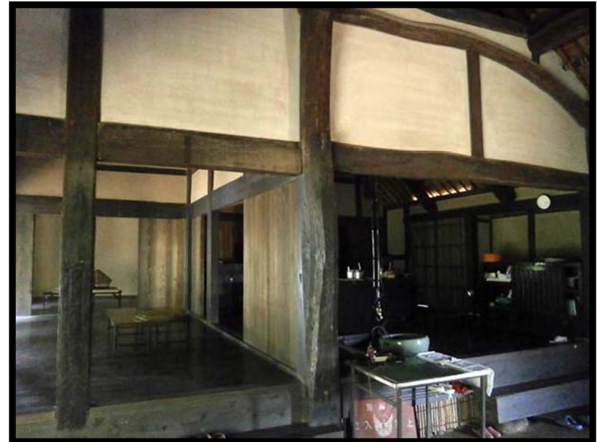
修復後の内部の様子
