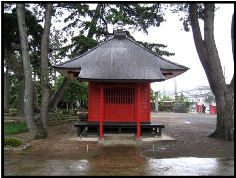
被災前の地藏堂の様子
