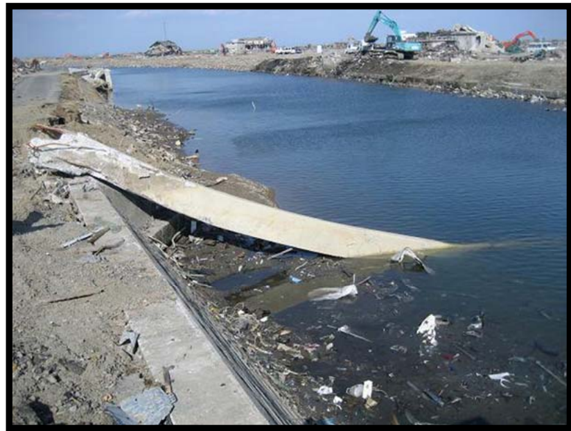
ていざんぼり 震災で貞山堀に落下した開運橋
