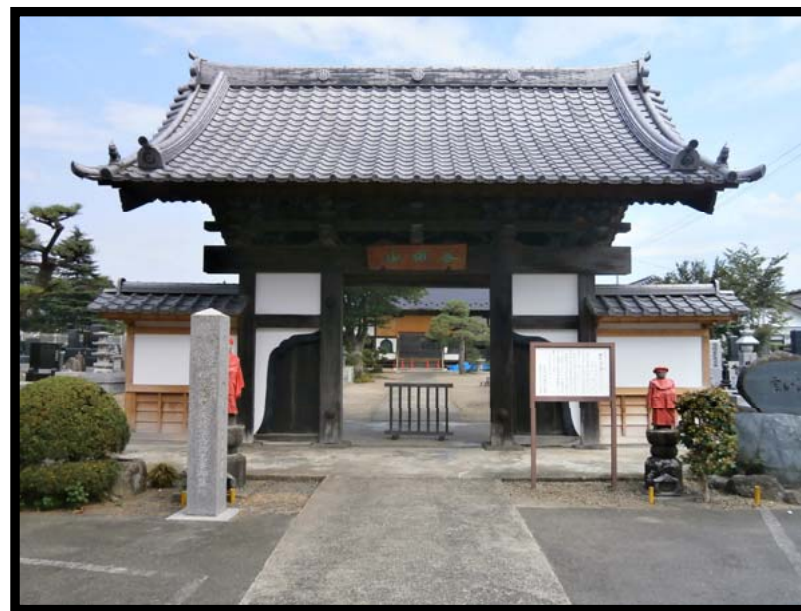
修理後の様子
