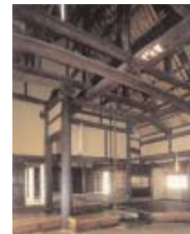
洞口家住宅の居室の様子
