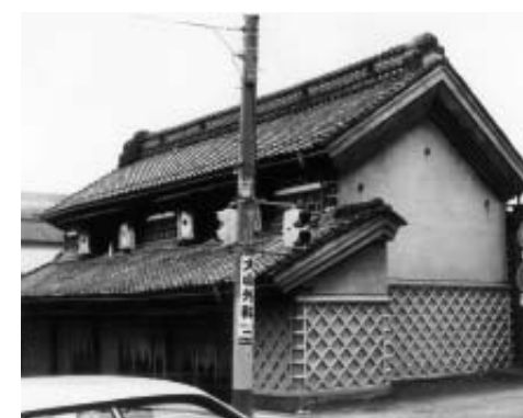
修理前の二階建土蔵造倉庫
