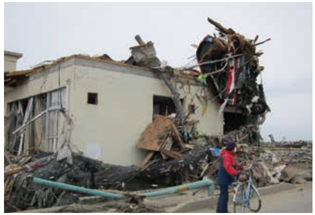
被害状況（閑上地区）
