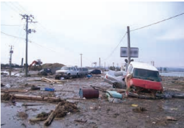
被害状況（下増田地区）
