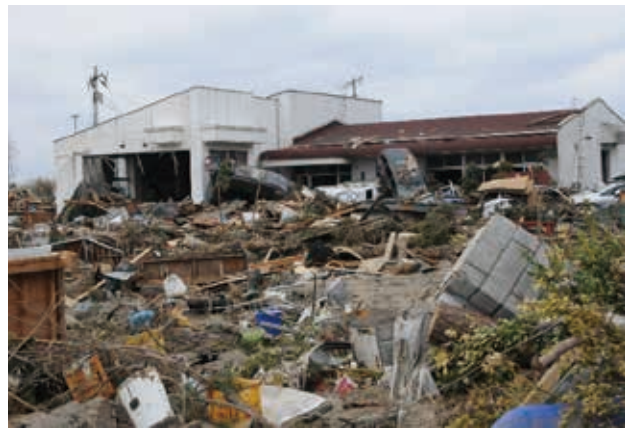
被害状況（下増田地区）
