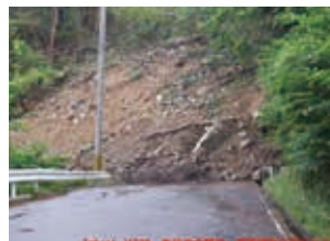
土砂で通行できなくなった道路
