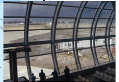
東日本大震災 (仙台空港ビル)
