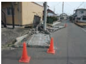
ブロック塀の倒壊 (名取市)
