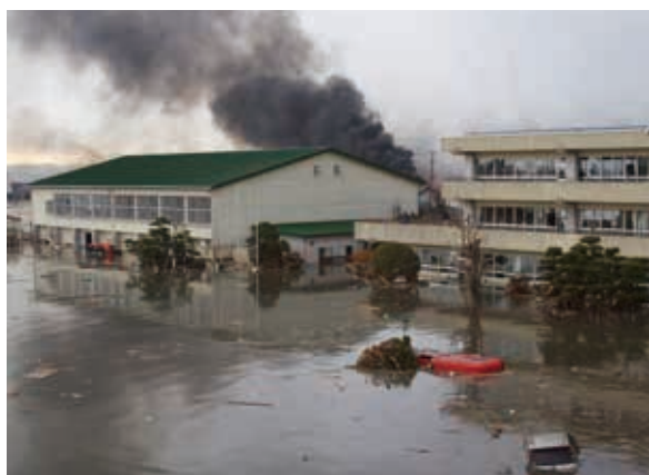
東日本大震災(閑上小学校)
