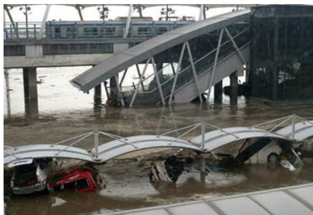
仙台空港の津波浸水状況
