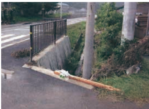
水難事故現場
