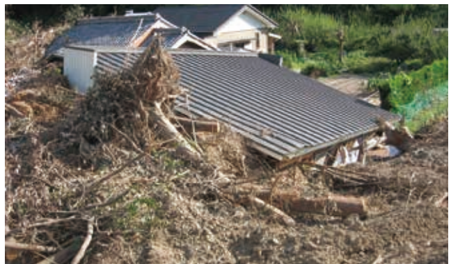
平成 23 年台風 12 号による被害状況 (和歌山県田辺市)
