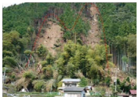
H23年台風15号によるがけ崩れ災害
