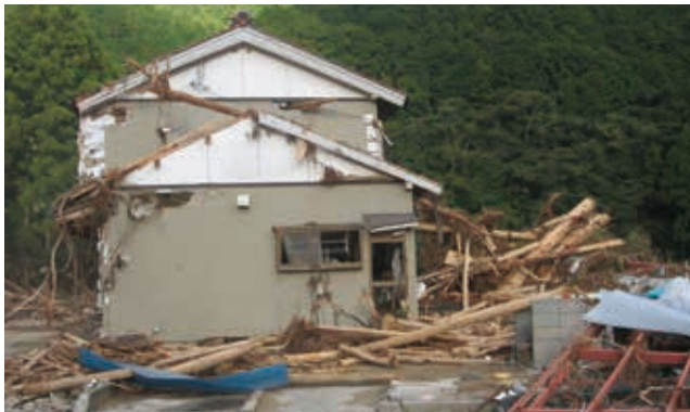
平成 23 年台風 12 号による被害状況 (和歌山県新宮市)
