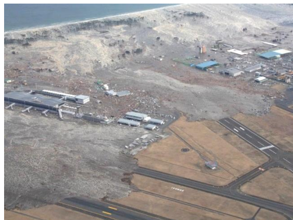
巨大津波にのみこまれていく 仙台空港※
