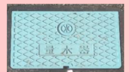
一般的なメーターボックス (開けると水道メーターが 入っています)
