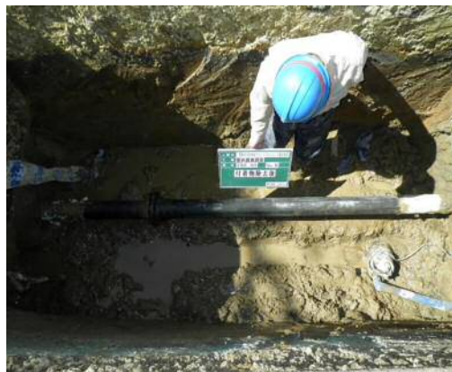
管路劣化調査の様子
