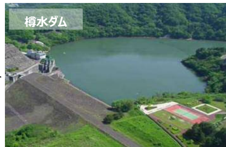
(写真提供：宮城県仙台地方ダム総合事務所)
