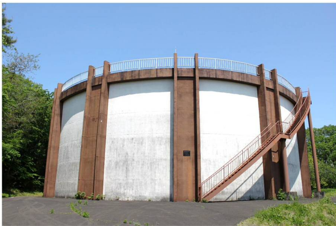
高館浄水場配水池
