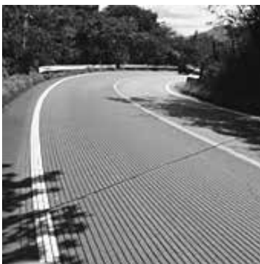
▲凍結抑制舗装の施工例
