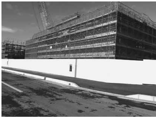
▲建設中の関上小・中学校
