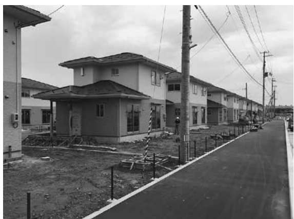
▲建設の進む関上地区第1期戸建て復興公営住宅
