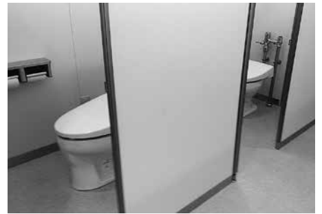
▲改修が終わった下増田小学校のトイレ
