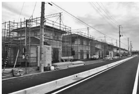
▲建築が進む閉上第1期復興公営住宅
