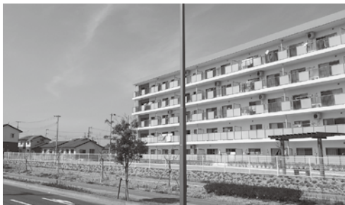
▲市営住宅と合わせて管理が委託される復興公営住宅
