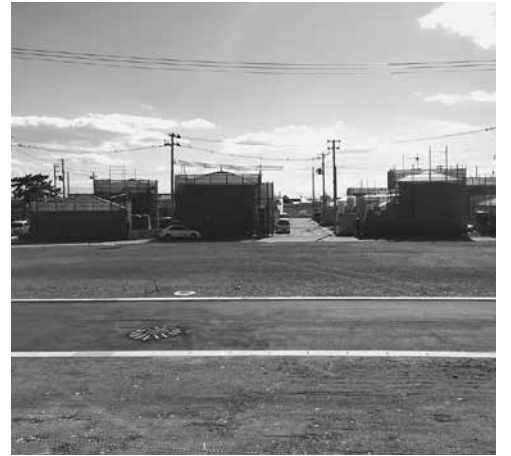
▲造成工事や復興公営住宅の建設が進む閉上地区
