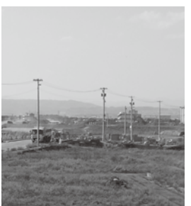
▲市街地整備工事が進む開上地区
