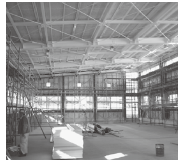
▲建設が進む第二中学校武道場
