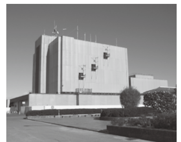
▲耐震補強工事が行われている 市役所庁舎
