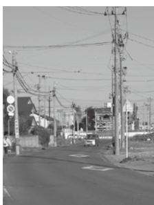
▲工事が進められる大手町下増田線
