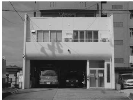
▲西部への移転改築が検討されている手倉田出張所
