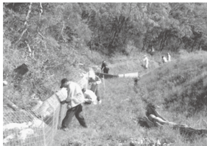
▲高館地区でのイノシシ侵入防止柵設置の様子
