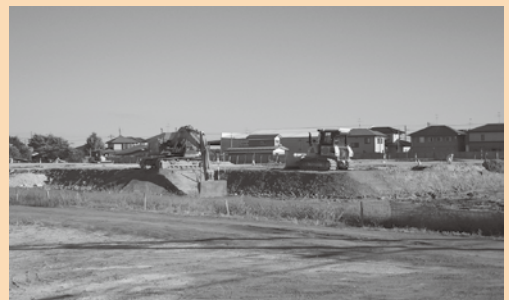
▲造成工事が進む復興公営戸建住宅用地（高柳地区）
