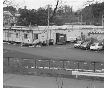
▲応急仮設住宅の全景
