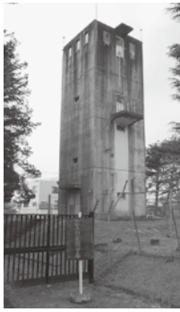
▶平成27年度での解体が予定されている名取が丘受水槽
