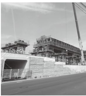
▲建設が進む大手町下増田線
