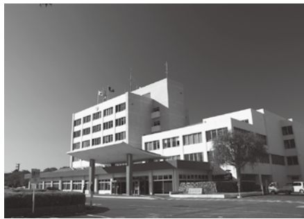
▲耐震補強等の工事が行われる市庁舎
