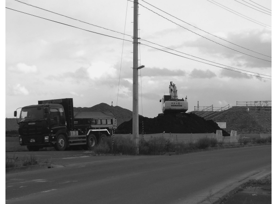
▲現在市内で進められている公共工事
