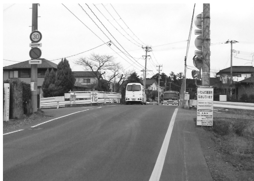
▲盛り上がった河内沢橋の通行状況
