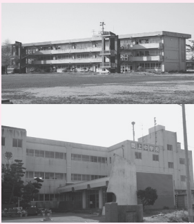
▲被災した閉上小・中学校
