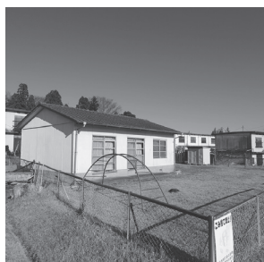
▲雨漏りの補修を行う名取団地集会所
