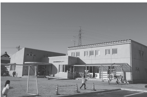
▲増設が予定されている増田西児童センター
