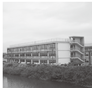
▲新校舎建築が進む下増田小学校
