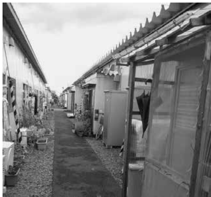
▲点検を予定している応急仮設住宅
