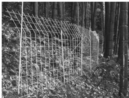
▲仙台市坪沼地区で設置した侵入防護柵
