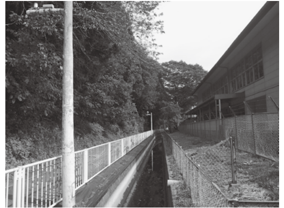
▲土砂災害警戒区域に指定されている館腰小学校西側の急傾斜地と遊歩道
