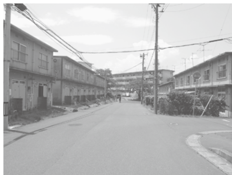
▲修繕と建てかえが必要な市営住宅
