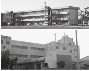
▲小中一貫校での再建が計画されている閉上小・中学校
