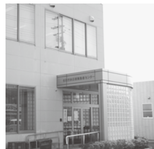
▲新たな施設が建設される休日夜間急患センター
