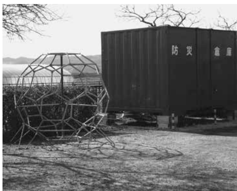
▲地域の公園に設置された防災倉庫
