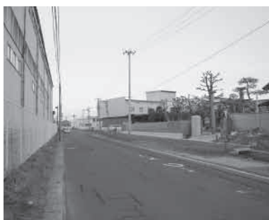
▲物件移転補償が完了する市道浜街道線
