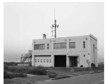
▲被災した消防車両が保管されている閉上出張所
