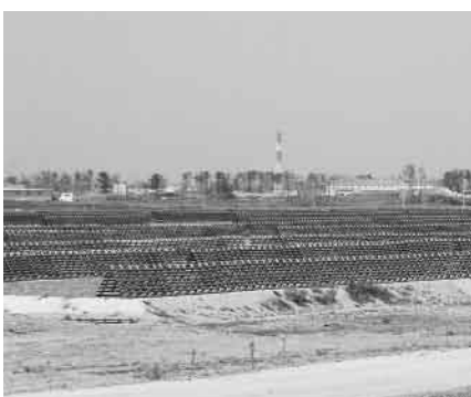
▲造成が完了した海岸防災林生育基盤(北釜地区)
