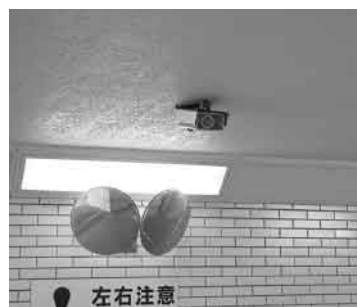
▲名取南地下歩道の監視カメラ
