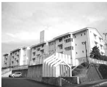
▲市営住宅箱塚団地
