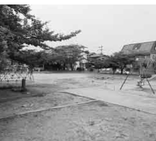
▲防火貯水槽が設置される名取が丘中央公園
