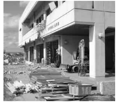
▲解体前の閉上公民館
