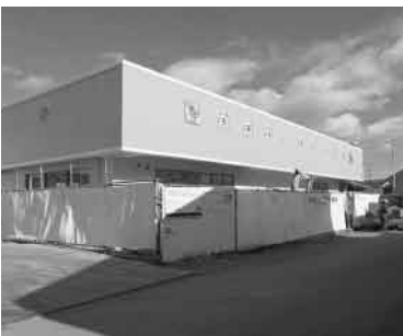
▲建設が進む(仮称)名取あけぼの保育園
