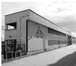
▲増設される名取駅西口自転車等駐車場
