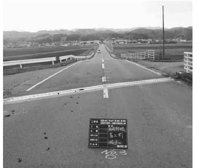
▲復旧工事が行われた市道松崎学市線
