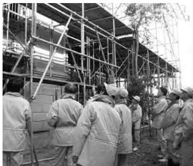
▲洞口家住宅座敷蔵の保存修理の様子
