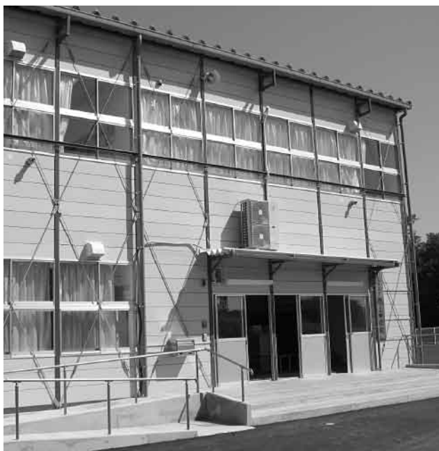
▲ 十三塚公園地内の関上中学校仮設校舎
