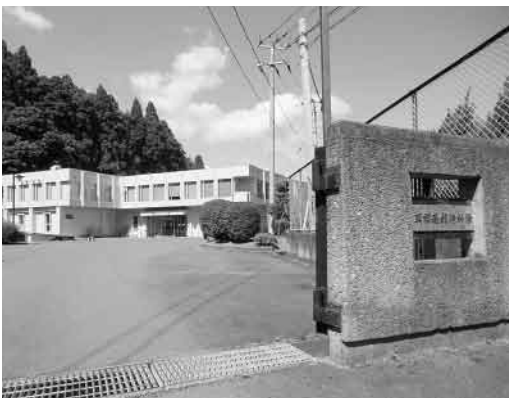
▲放射性物質を含んだ浄水発生土を保管している高館浄水場
