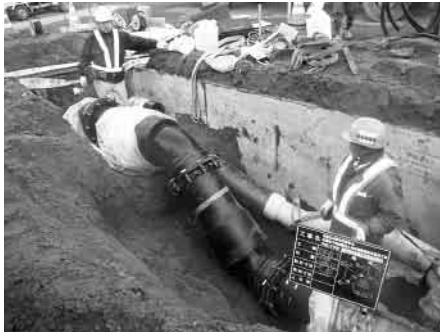
▶耐震管敷設工事
