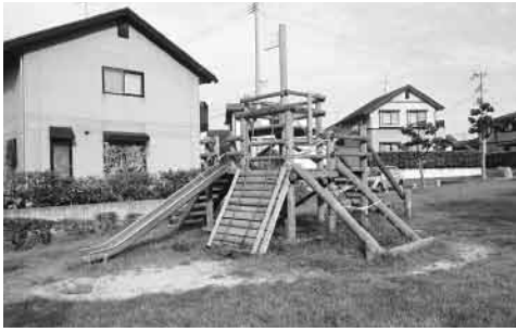
▲老朽化により使用できなくなった遊具
