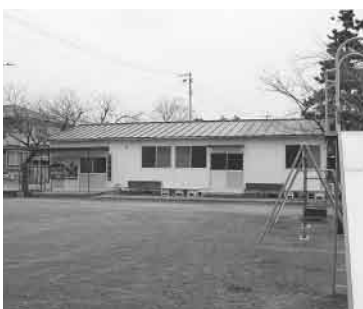
▲ 復旧予定の大曲集会所
