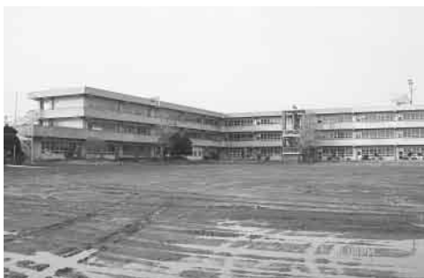
▲被災した閉上小学校
