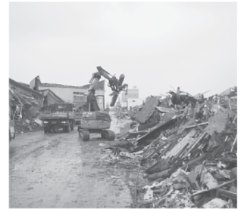
▲震災時の瓦れき撤去の様子
