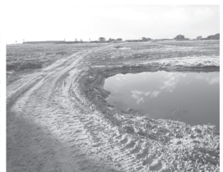
▶災害復旧関連区画整理事業が検討されている被災圃場
