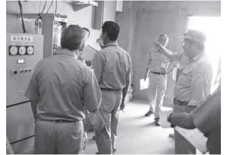
▲委員会での防災行政無線の調査の様子
