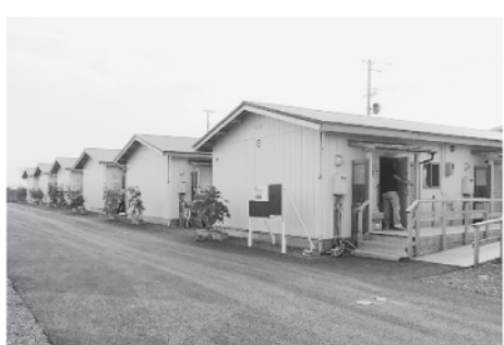
▲ 市内の仮設住宅
