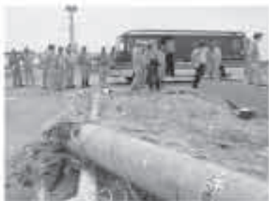
▲(仮称)東日本大震災復興調査委員会での現地調査
