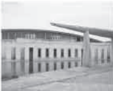
▲瓦れき撤去を行った名取市斎場
