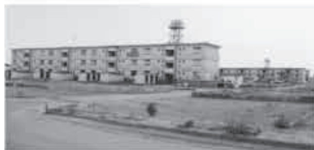
▲被災した関上地区の市営住宅
