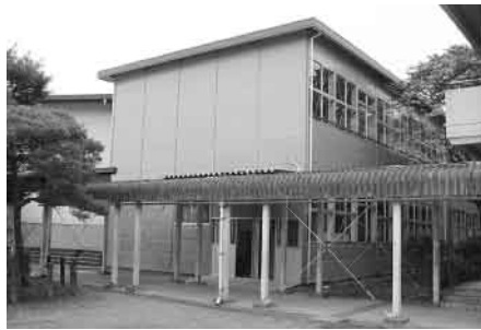
▲ 四教室増設となる愛島小学校仮設校舎
