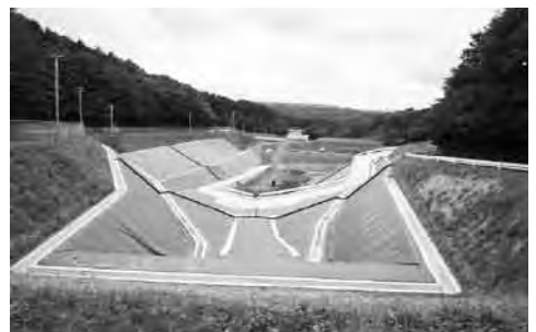
▲ 岩沼市にあるオープン型最終処分場
