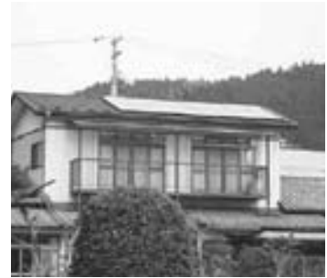
▲太陽光発電システムを設置した家屋
